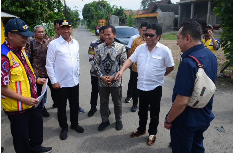
Ketua Tim Kunsfik Komisi V DPR Ridwan Bae, bersama tim, saat meninjau infrastruktur jalan yang mengalami kerusakan di Kabupaten Tulungagung, Provinsi Jawa Timur, Jumat (23/5/2025).
