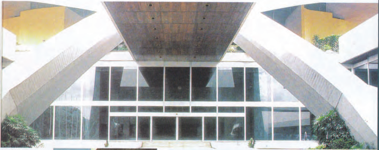
Balok pendukung atap kubah ruang sidang utama yang perkasa, juga indah.
