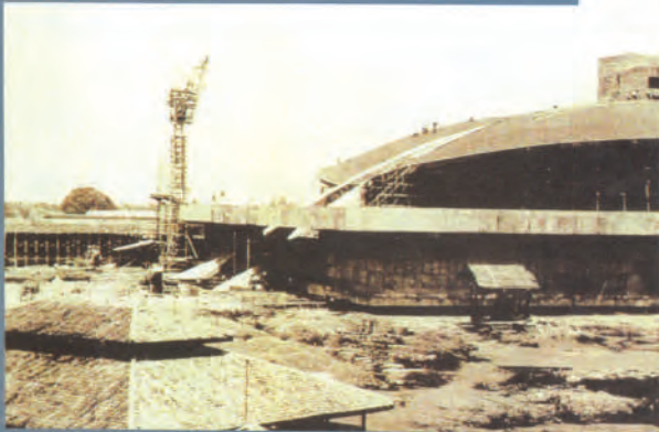
Sosok bangunan Main Conference Building/Gedung Sidang Utama ketika konstruksi perancah mulai dibongkar.
