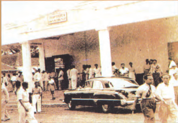
Gedung Loge Theosofie di jalan Malioboro Yogyakarta
